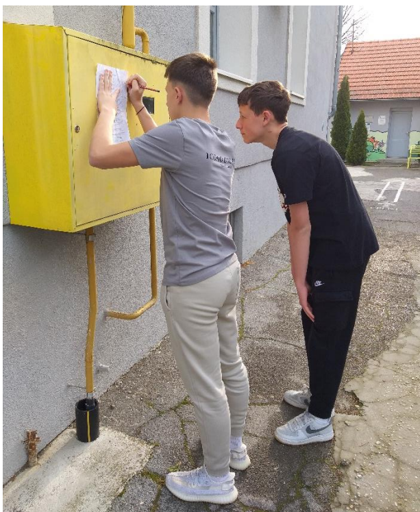
Očitavanje plina u istočnoj zgradi
